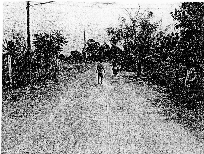
รูปแสดงที่ 2 สถานที่ก่อสร้าง ขณะสำรวจตั้งงบประมาณ
