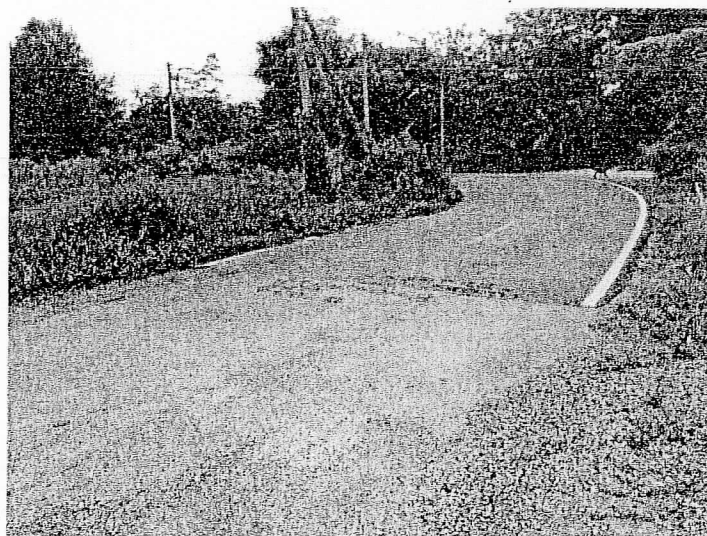
รูปแสดงที่ 8 สถานที่ก่อสร้าง เมื่อดำเนินการก่อสร้าง
